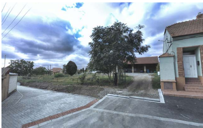
pohled od východu
