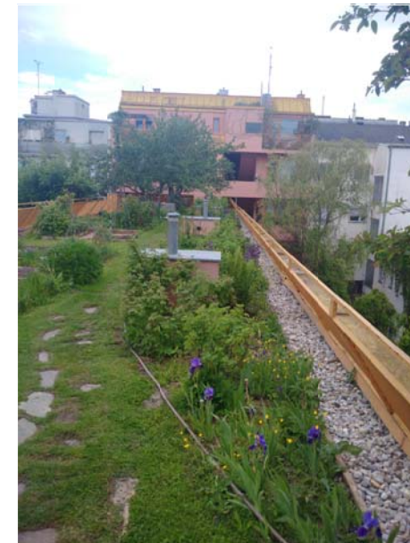
pobytová zelená střecha bytového domu, Vídeň
